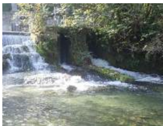
Photo 15 : Vanne latérale du canal rive gauche
