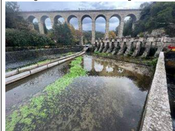
L'aménagement de transit du Barrage de Galas
