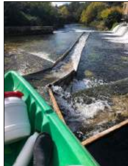
Photo 4 : Passe à kayak sur le seuil de Galas
